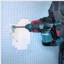
Идеален для удаления штукатурки, строительного мусора, старой плитки. Регулировка количества ударов от степени нажатия на триггерный переключатель. Блокировка триггерного переключателя в включённом положении для удобства при продолжительной и непрерывной работе. Пять установок количества ударов регулировочным диском на электронном блоке. Задняя рукоятка оснащена системой поглощения вибрации. 12 положений установки угла долота.
