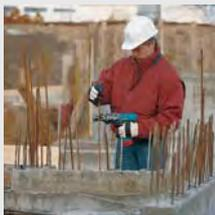
Точная и быстрая резка монтажных стержней с резкой без повреждения резьбы, искр, шума и пыли.
